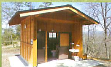
障害者用トイレ
